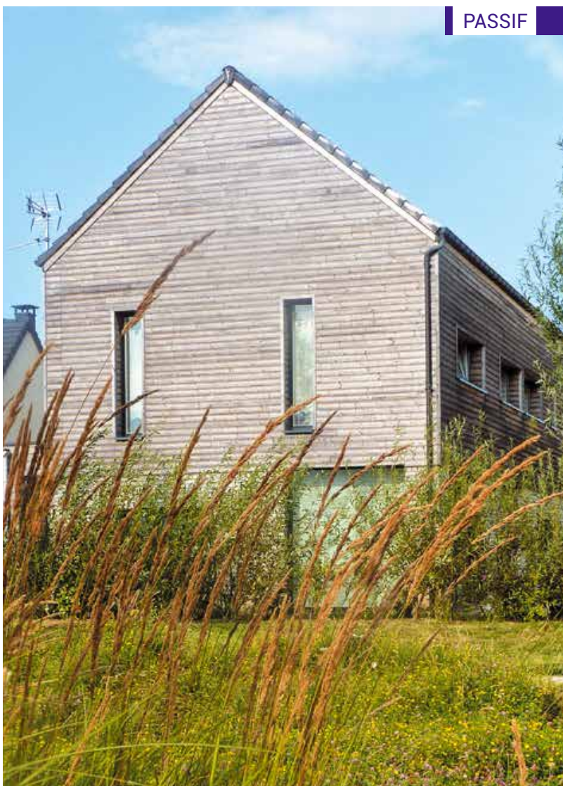
Le choix de l'ossature bois a permis non seulement de satisfaire à la démarche passive mais aussi de réduire notablement les délais de montage. Le tout avec un bilan carbone très satisfaisant.
